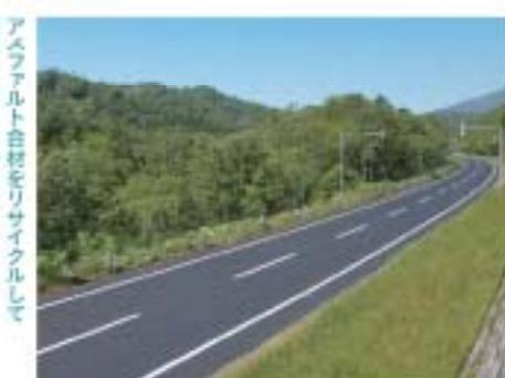
アスファルト合材をリサイクルして舗装修繕した二級国道244号
